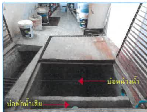
ภาพถ่ายที่ 2.2-13 บ่อหน้าน้ำและบ่อพักน้ำเสีย พร้อมตะแกรงดักมูลฝอย
