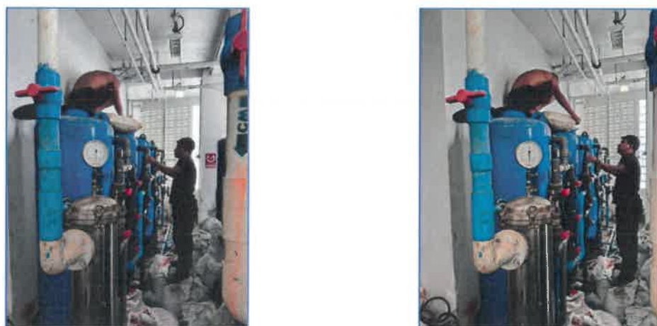
ภาพถ่ายที่ 2.2-11(2) การล้างทำความสะอาดถังน้ำใช้และระบบกรองน้ำใช้
