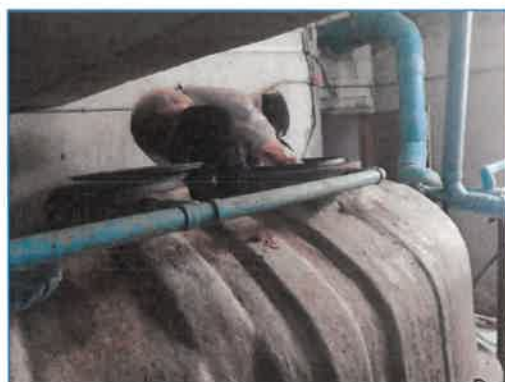
ภาพถ่ายที่ 2.2-16(4) การลอกตะกอนจากถังตกตะกอน
