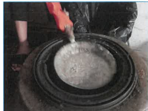
ภาพถ่ายที่ 2.2-16(3) การตัดกากไขมัน
