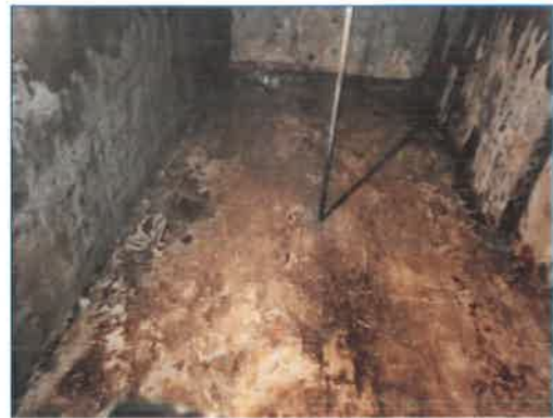
ภาพถ่ายที่ 2.2-11(2) การล้างทำความสะอาดถึงน้ำใช้และระบบกรองน้ำใช้ (ต่อ)
