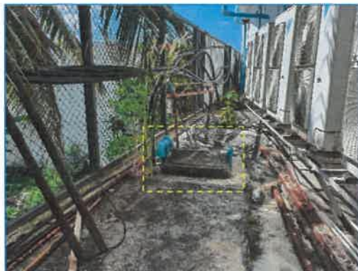
ภาพถ่ายที่ 2.2-16(2) ระบบท่อ vent พีวีซีเพื่อระบาย ก๊าซมีเทน
